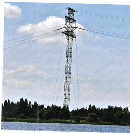
Рис. 5. Правобережная промежуточная «качающаяся» опора на оттяжках на совмещенном переходе ВЛ 500/220 кВ через Волгу у Костромы (фото автора, июль 2021)
