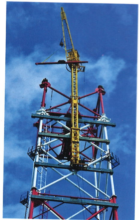
Рис. 11. Левобережная анкерная опора АТ-73М на затопляемом половодьем берегу, установленная на четыре стойки монолитных железобетонных ростверков, и ледозащита из 25-ти надолб, объединенных распорками. Поэлементный монтаж способом наращивания при помощи «ползучего» крана (фото автора, август 2021 года)
