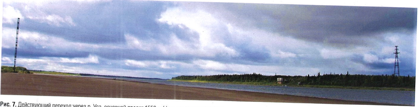
Рис. 7. Действующий переход через р. Уса, основной пролет 1550 м (фото автора, июль 2007)
