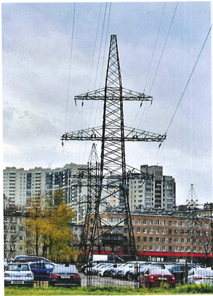
Рис. 2. Типовая переходная промежуточная двухцепная опора ВЛ 110 кВ ПАО «Ленэнерго» № 15 на левом берегу Невы (на правом берегу такая же опора № 16) и конечная анкерная опора № 14 (фото автора, октябрь 2021)
