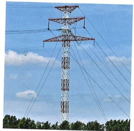
Рис. 5. Правобережная промежуточная «качающаяся» опора на оттяжках на совмещенном переходе ВЛ 500/220 кВ через Волгу у Костромы (фото автора, июль 2021)
