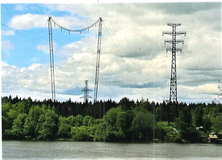
Рис. 3. Специальный двухцепный переход ВЛ 110 кВ Л1-Л2 ПАО «Ленэнерго» у г. Кировск (Ленинградская область) на промежуточных опорах ПГТ110-2/70 с гибкой вантовой или тросовой траверсой и Л-образными оттяжками. Это один из первых переходов через Неву, разрушенный во время Великой Отечественной войны и затем восстановленный [3] (фото автора, июль 2017)
