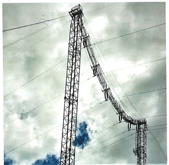
Рис. 3. Специальный двухцепный переход ВЛ 110 кВ Л1-Л2 ПАО «Ленэнерго» у г. Кировск (Ленинградская область) на промежуточных опорах ПГТ110-2/70 с гибкой вантовой или тросовой траверсой и Л-образными оттяжками. Это один из первых переходов через Неву, разрушенный во время Великой Отечественной войны и затем восстановленный [3] (фото автора, июль 2017)
