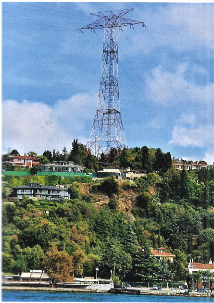
Рис. 1. Однопролетные переходы по схеме 1: правая анкерная опора ВЛ 154 кВ на азиатском берегу пролива через Босфор (фото автора, октябрь 2021); торжественное открытие энергомоста ВЛ 330 кВ через р. Преголя: заход парусника «Крузенштерн» в Морские ворота Калининграда [5] (06.10.2018)
