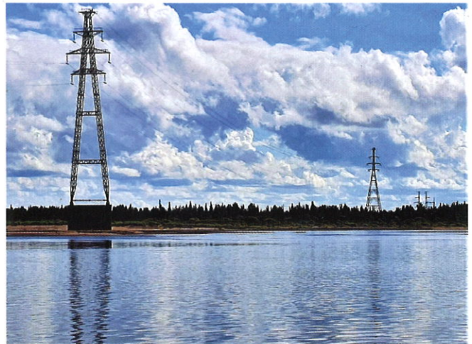
Рис. 6. Специальный переход ВЛ 220 кВ «Ухта-Печора» (переход № 1) через р. Печора: правый (пролет 740 м) и левый (660 м) берега, на среднем плане русловая «качающаяся» опора СПК-74 (фото автора, август 2004)
