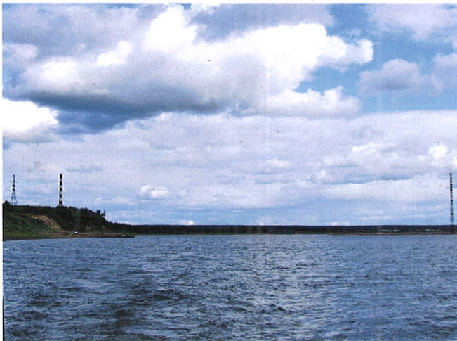
Рис. 6. Специальный переход ВЛ 220 кВ «Ухта-Печора» (переход № 1) через р. Печора: правый (пролет 740 м) и левый (660 м) берега, на среднем плане русловая «качающаяся» опора СПК-74 (фото автора, август 2004)
