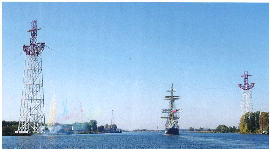
Рис. 1. Однопролетные переходы по схеме 1: правая анкерная опора ВЛ 154 кВ на азиатском берегу пролива через Босфор (фото автора, октябрь 2021); торжественное открытие энергомоста ВЛ 330 кВ через р. Преголя: заход парусника «Крузенштерн» в Морские ворота Калининграда [5] (06.10.2018)
