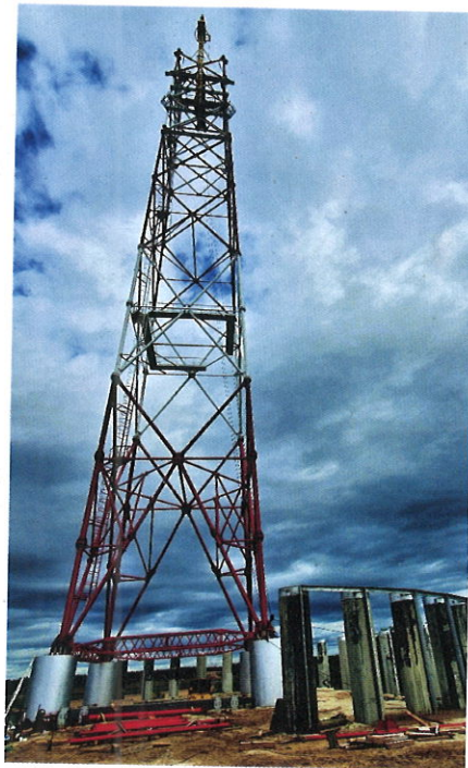
Рис. 11. Левобережная анкерная опора АТ-73М на затопляемом половодьем берегу, установленная на четыре стойки монолитных железобетонных ростверков, и ледозащита из 25-ти надолб, объединенных распорками. Поэлементный монтаж способом наращивания при помощи «ползучего» крана (фото автора, август 2021 года)
